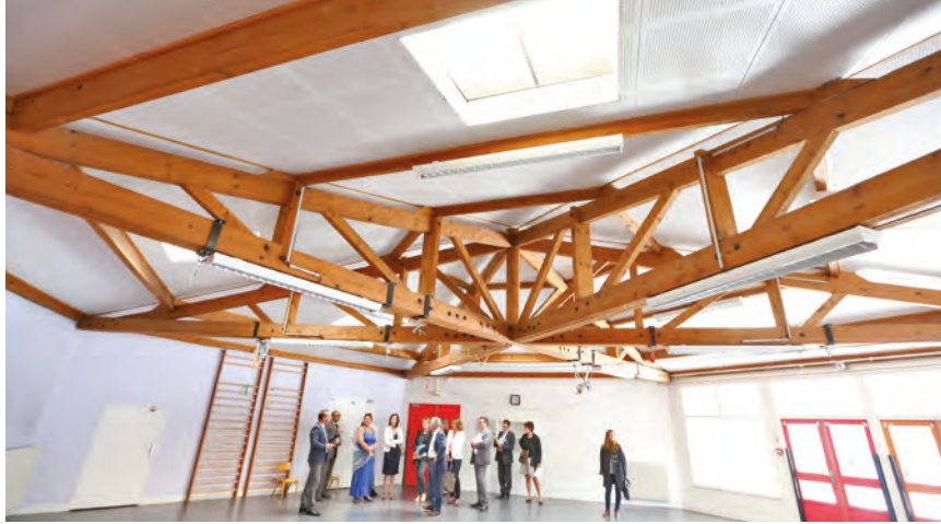
■ Maternelle Gallieni. 45 000 euros dédiés à différents travaux dont la rénovation du plafond de la salle de psychomotricité.
