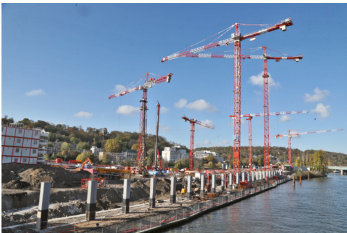
■ Vue du chantier, novembre 2014.
