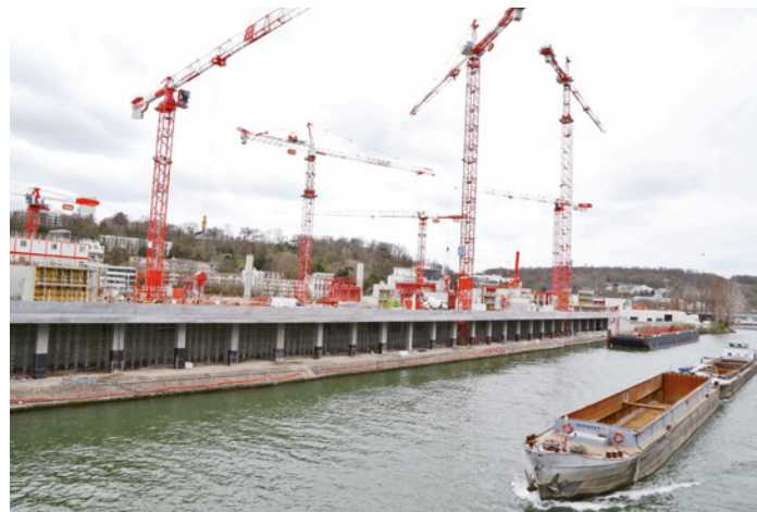
■ Mars 2015, les travaux avancent à bon rythme sur l'île Seguin.
