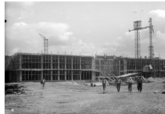
■ Façade principale de l'hôtel de ville en cours de construction, vers 1931. Cette photographie permet d'apprécier les structures en béton du bâtiment des réceptions que le comblanchien de la façade ne laisse pas deviner.
