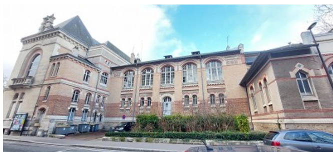
Vue latérale (ouest)
