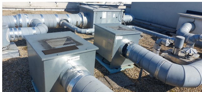
Sorties de VMC « halte garderie » et « crèche collective ».
