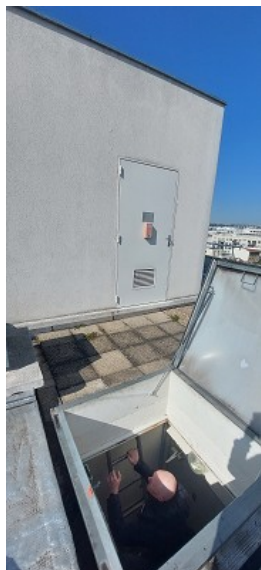
Accès au toit depuis le lanterneau
