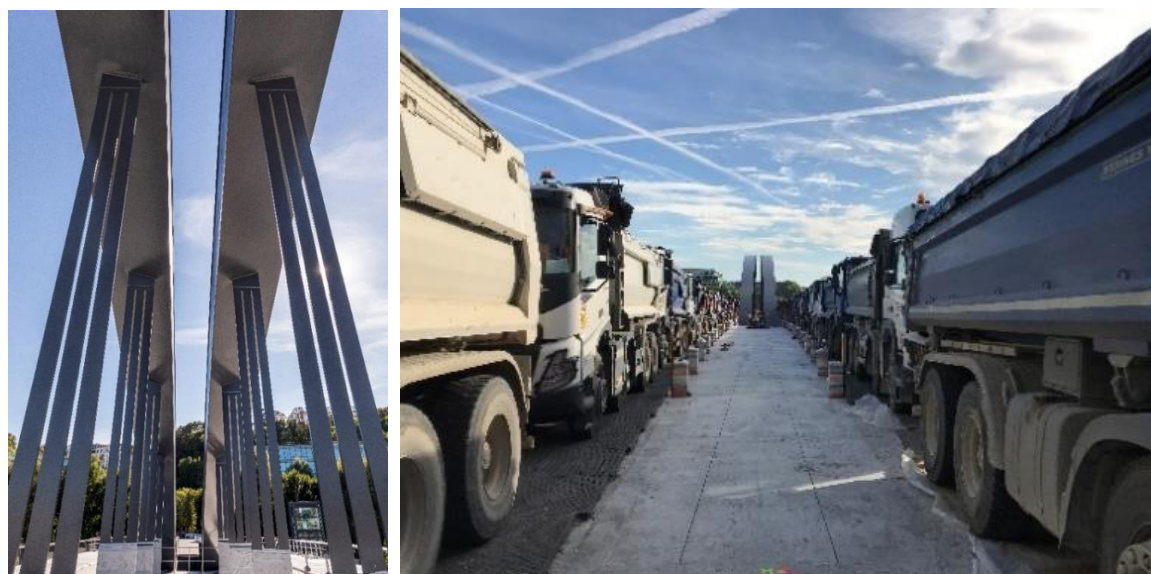
Opération de lancement du pont au-dessus de la Seine (SPL – 2021)
